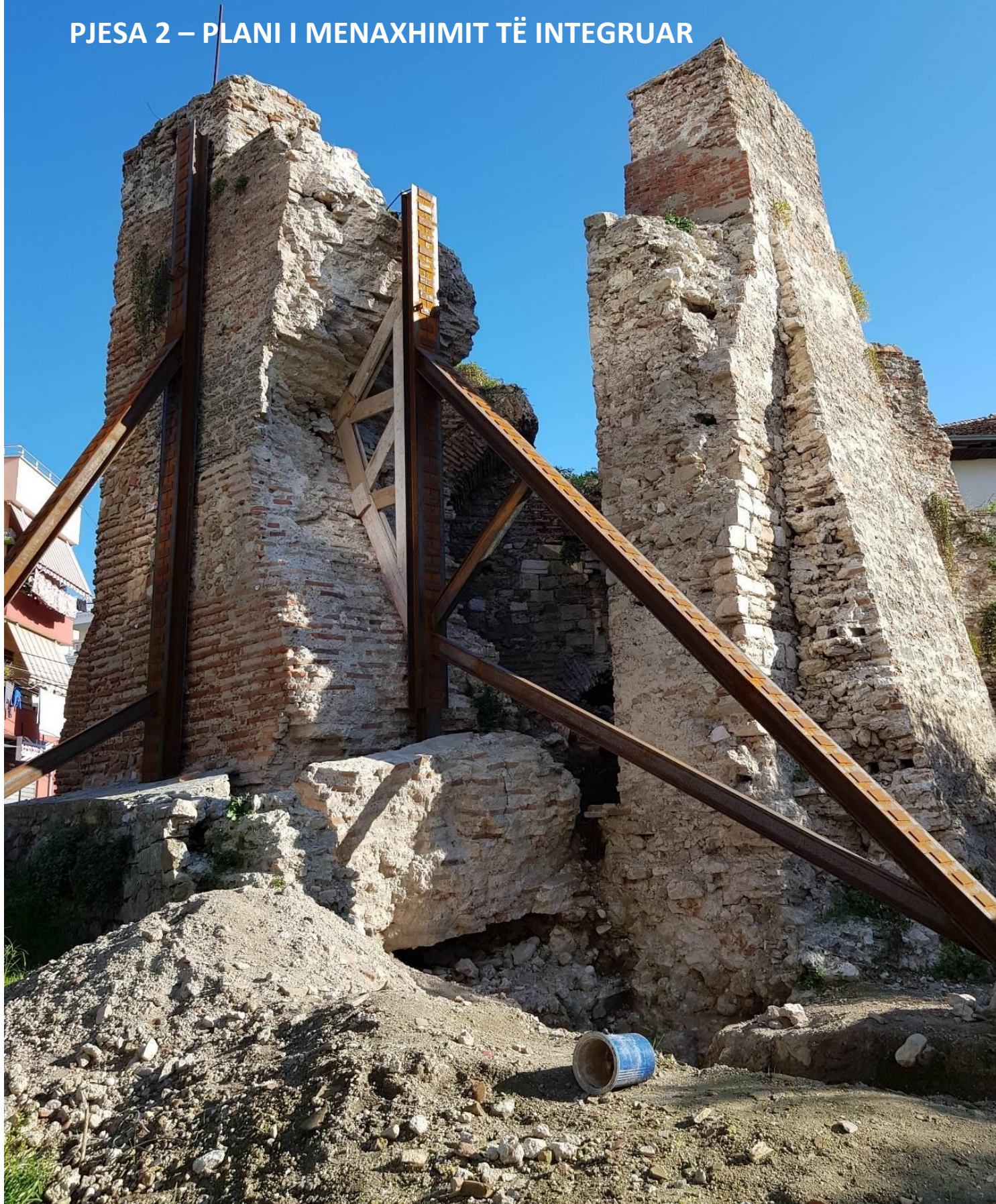
Figurë 66 – Pjesa e jashtme e Kullës C, stabilizimi i kullës Bizantine, e cila u shemb gjatë tërmetit 2019
