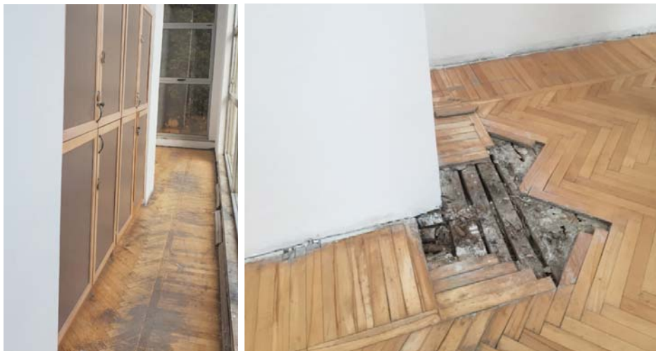
Figura 11.12 Demtimet e shfaqura ne dysHEME
