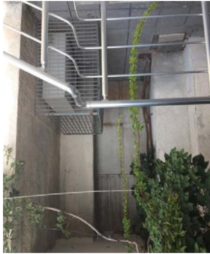
Figura 21.22. Gjendja ekzistuese e fasadës lindore. Evidentimi i vegjetacionit dhe vendosjes së pajisjeve.
