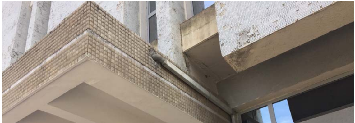
Figura 13. Gjendja ekzistuese e fasadës kryesore. Dalja e tubacioneve dhe shkeputja e mozaikut.
